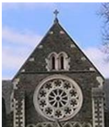
(شكل 18) جزء من الواجهة القديمة
