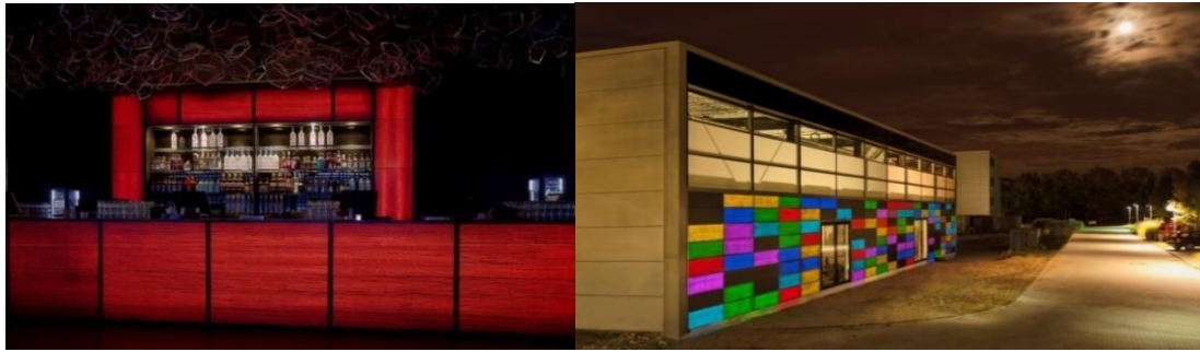
صورة (٢٩، ٣٠): "استخدام الخرسانة الملونة الناقلة للضوء في الواجهات الخارجية وأعمال التصميم الداخلي". (١٢)
