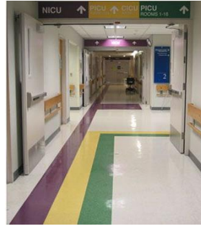
شكل (٤) استخدام الألوان في تشطيب الأرضيات لتحديد مسارات الوصول بـ [27] Denver Children's Hospital
