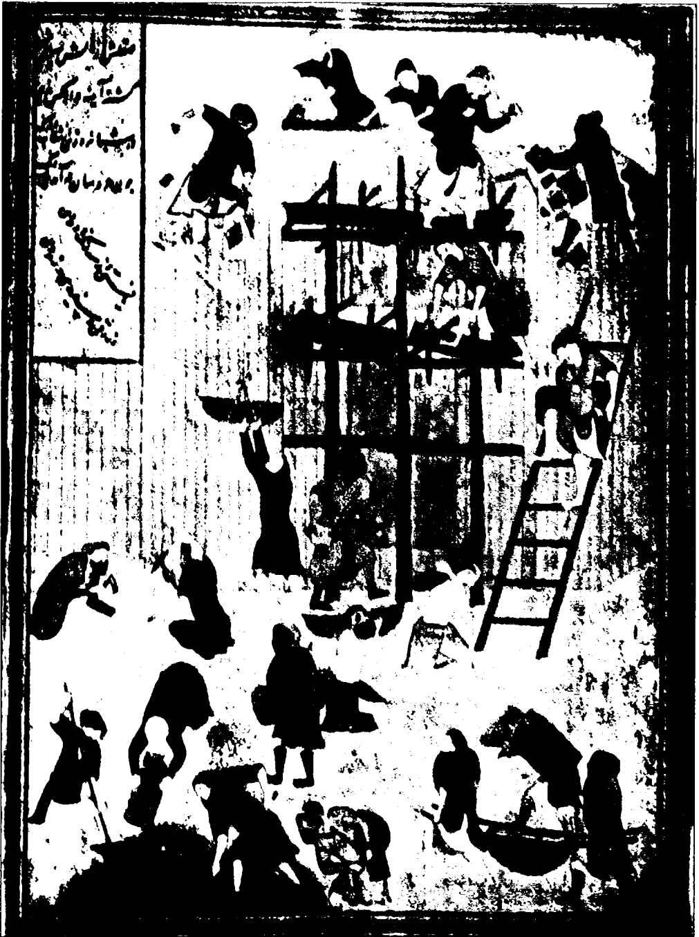
٣٢- خمسة، نظامي- بناء قلعة خورنق الشهيرة عام ١٤٩٤ الرسوم من عمل بهزاد. تبدو في اللوحة حركة العمال منسجمة و متوافقة مع طبيعة العمل الذي شكل بمجمله تسجيلاً صادقاً لتلك اللحظة
