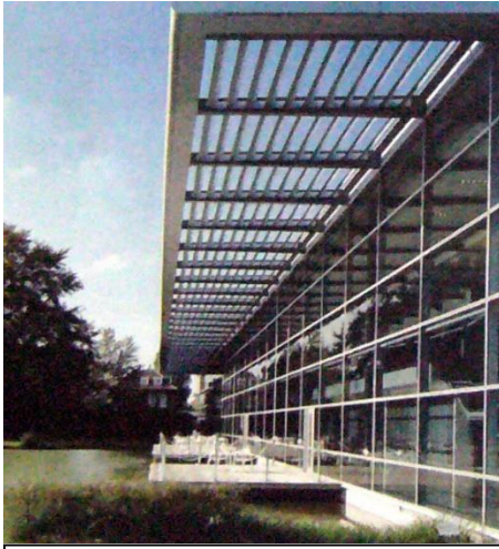
صورة (٢) اقترح "Mike Davies" للواجهات "Polyvalent Wall" الذي يفترض فيه عدة طبقات للغلاف الخارجي للمبنى تتحكم في وظائف التحكم الحراري والعزل.
