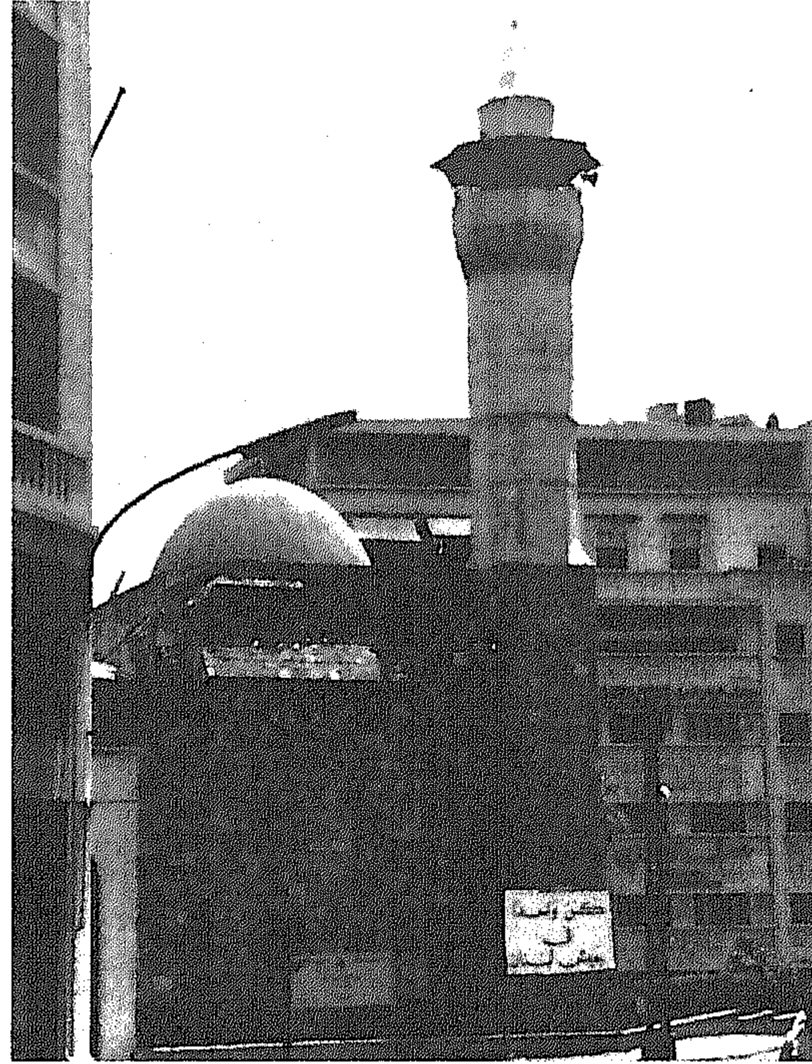
صورة ٥٤ - الواجهة الغربية ( الجزء الجنوبي )
