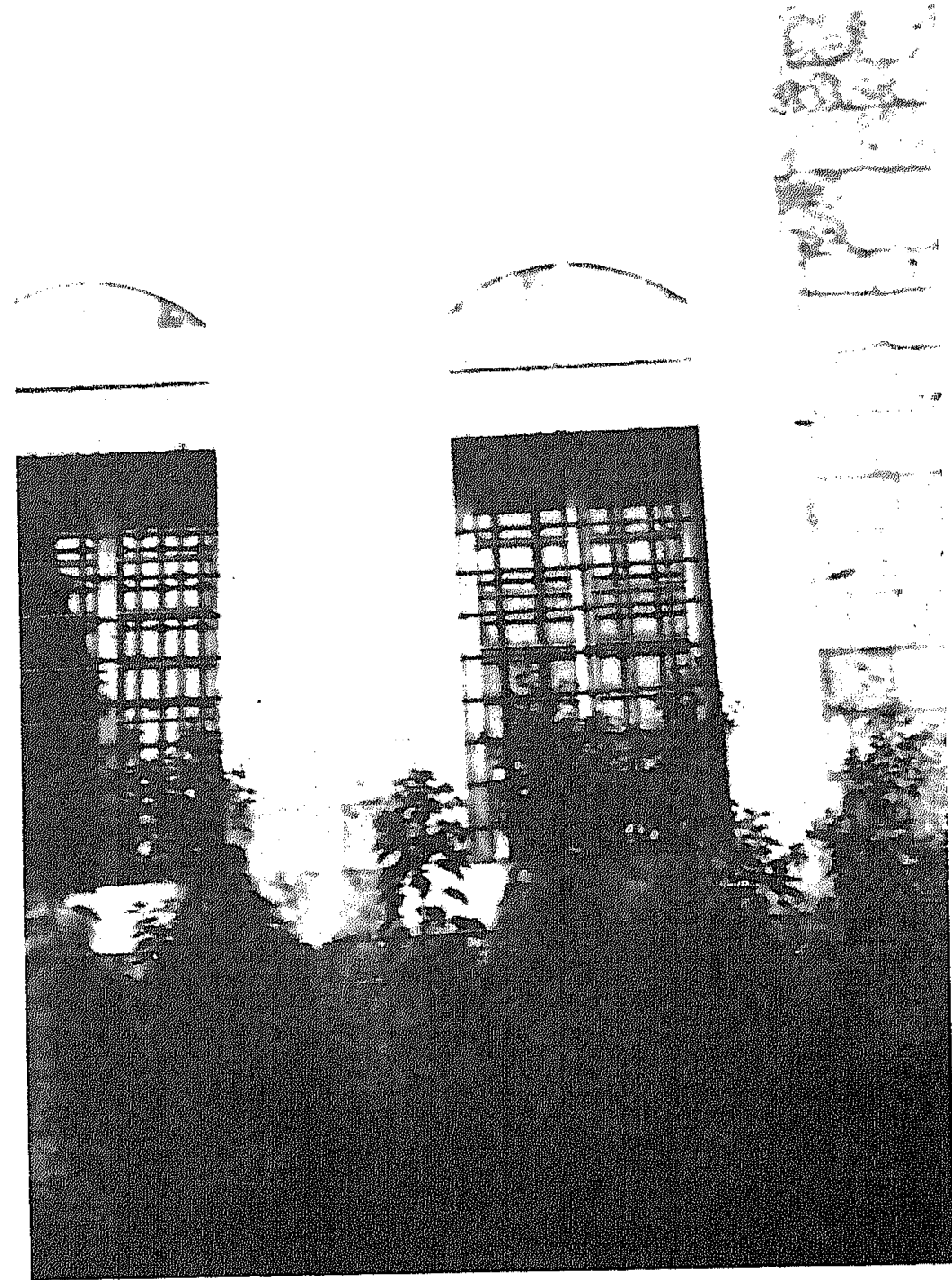
صورة ٥٥ - تفاصيل بالواجهة الشرقية
