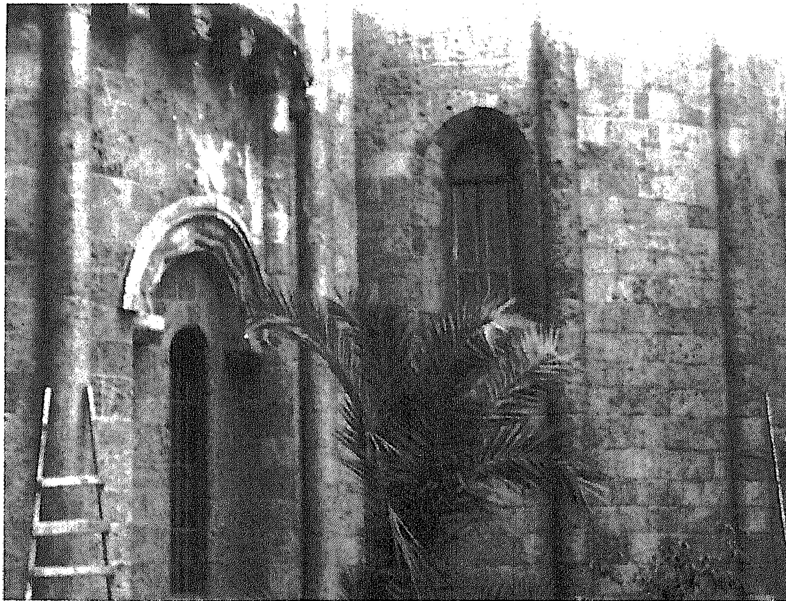
صورة ٣ - الواجهة الشرقية
