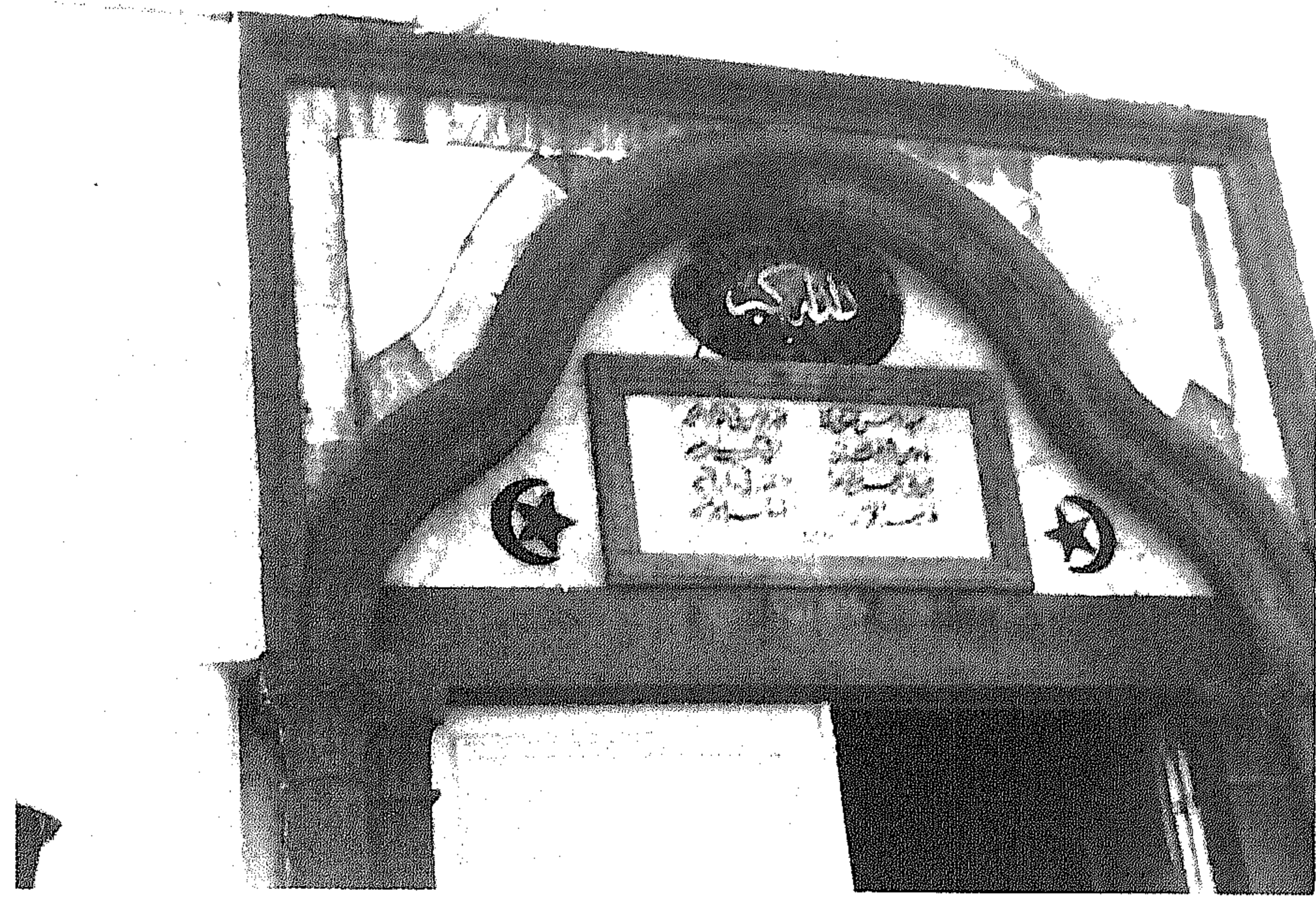
صورة ١٠٤ - تفاصيل عقد المدخل الشمالي
