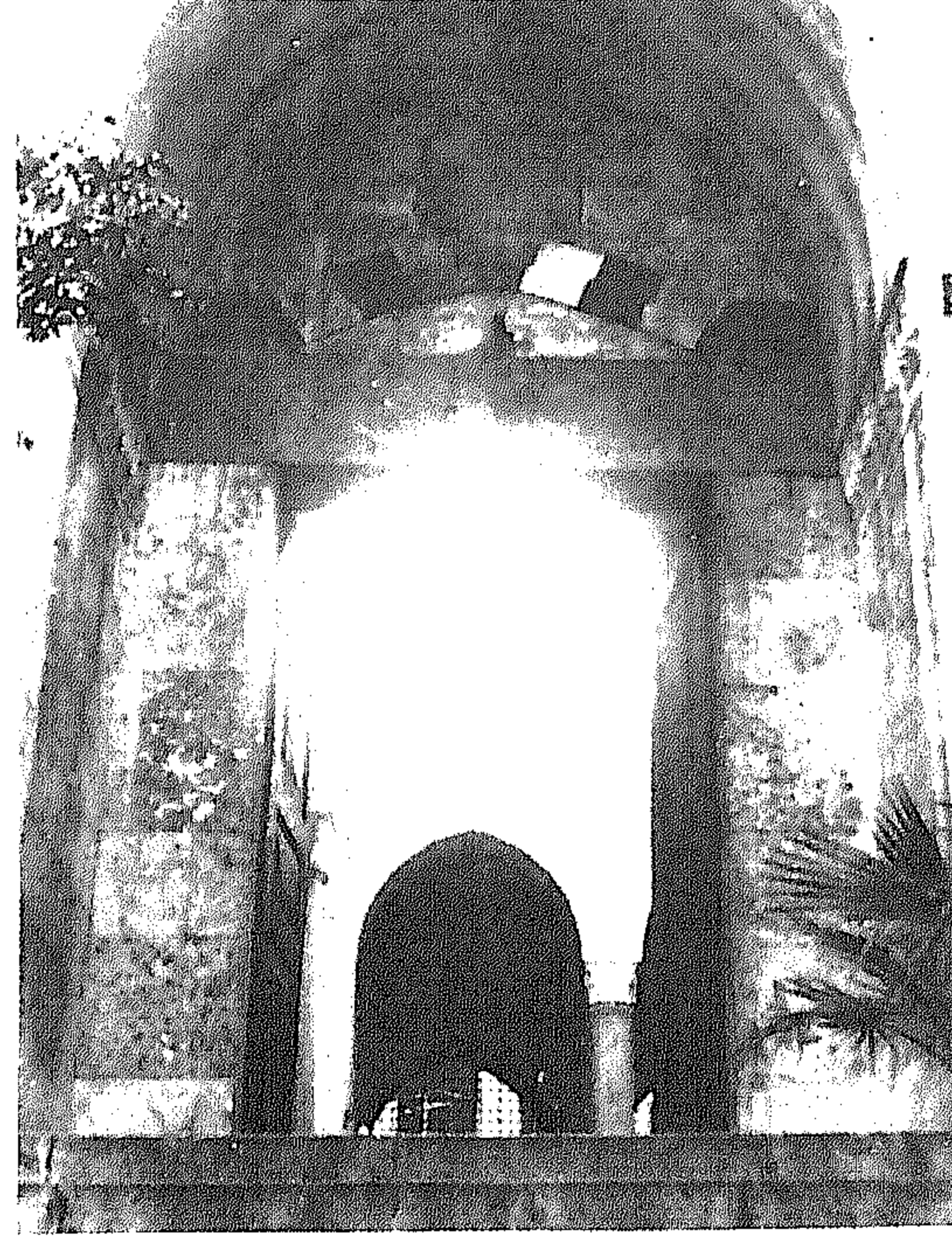
صورة ٤٥ - المدخل بالواجهة الشرقية
