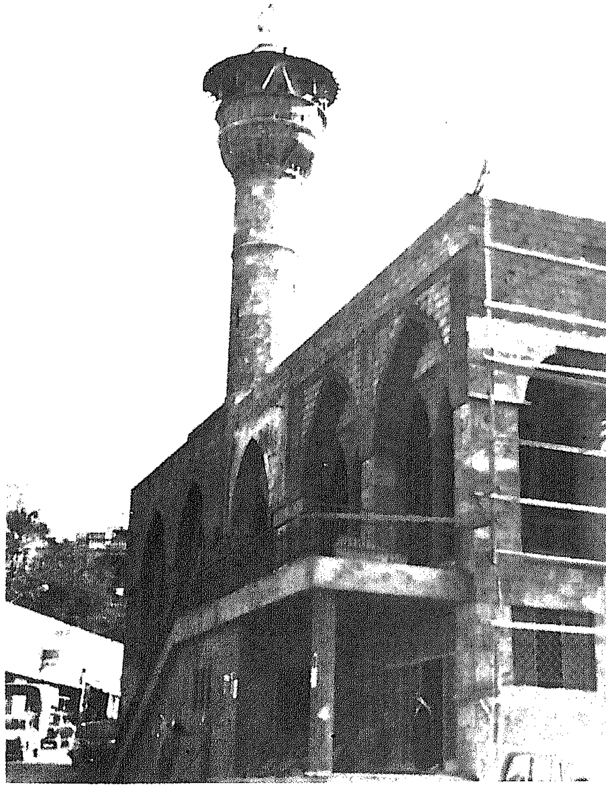
صورة ٩٦ - الواجهة الشرقية
