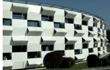
شكل (٧،٦،٥) تتغير شكل الواجهة فتح الوحدات وغلقها كما تتفاعل مع الظروف المناخية. [١١]
