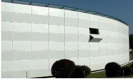
شكل (٤) واجهة معرض Kiefer Technic، تفاعل ديناميكي مبرمج، مزودة بنظام برمجي للفتح والغلق إلكترونياً.
