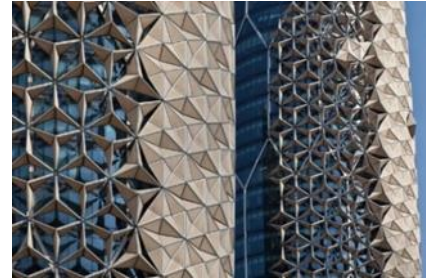
شكل (١٤) تتفاعل الوحدات على الواجهة بالانفتاح والانغلاق حسب قوة أشعة الشمس، شكل (١٥) الوحدات منفتحة عند توهج أشعة الشمس، شكل (١٦) الوحدات منغلقة بالكامل في الليل.
