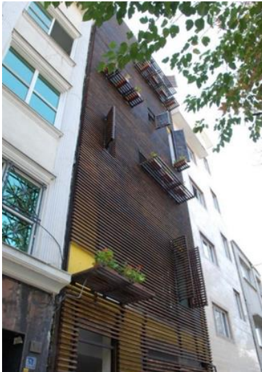
شكل (١٩ & ٢٠) واجهة ديناميكية شرائط خشبية مثبتة بمفصلات التحريك تشكل نوافذ وجلسات لأوعية الزهور، تتناغم مع المحيط البيئي.
