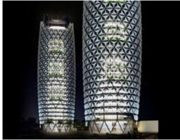
شكل (١٤) تتفاعل الوحدات على الواجهة بالانفتاح والانغلاق حسب قوة أشعة الشمس، شكل (١٥) الوحدات منفتحة عند توهج أشعة الشمس، شكل (١٦) الوحدات منغلقة بالكامل في الليل.
