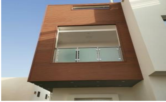
شكل (٣٩) جزء من تغطية واجهة المبنى من الاخشاب البلاستيكية بمظهر الاخشاب الطبيعية.
