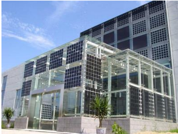
شكل (٣٨) زجاج نوافذ المبنى مزود بالأواح من مكثفات الطاقة الشمسية يمكنه تخزين الطاقة، كما يمكن تنظيفه وصيانته.
