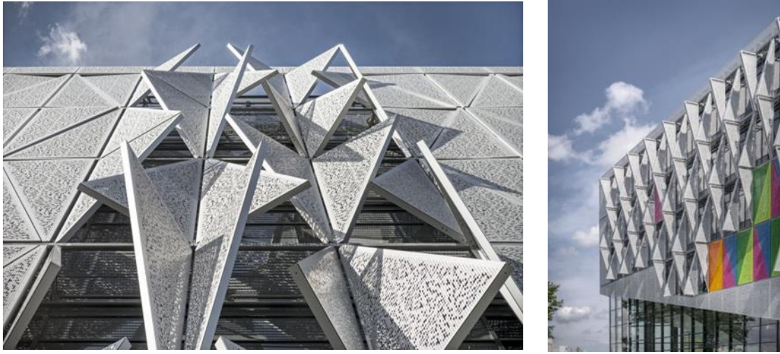
شكل (٢٢&٢١) الواجهة تتفاعل ديناميكياً من خلال وحدات ظليلة تتحرك من خلال الفتح والغلق بواسطة نظام برمجي يتوقف على شدة أشعة الشمس.
