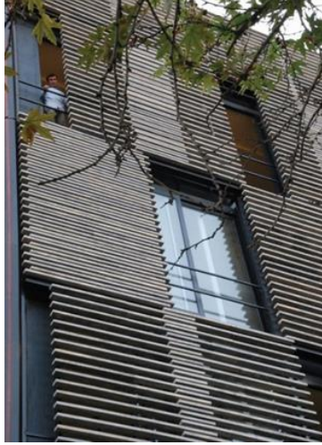
شكل (١٧ & ١٨) واجهة ديناميكية من الشرائط الخشبية المنزلقة، تتحرك بواسطة المستخدم.
