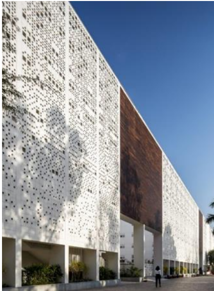
شكل (٣) أحد الواجهات بعد تركيب الواح التكبسية فوق هيكل التثبيت، الواح من الألومنيوم المفرغ تعمل على تقليل حرارة المبنى، ومقاومة العوامل الجوية.
