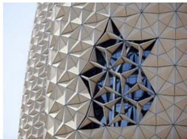
شكل (١٤) تتفاعل الوحدات على الواجهة بالانفتاح والانغلاق حسب قوة أشعة الشمس، شكل (١٥) الوحدات منفتحة عند توهج أشعة الشمس، شكل (١٦) الوحدات منغلقة بالكامل في الليل.
