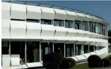
شكل (٧،٦،٥) تتغير شكل الواجهة فتح الوحدات وغلقها كما تتفاعل مع الظروف المناخية. [١١]
