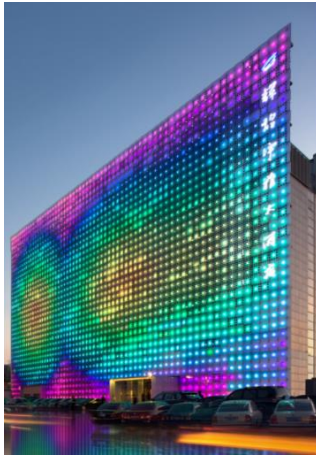
شكل (٢٣) واجهة تفاعلية "مبنى جدار الوسائط الرقمية المستدامة" بتكنولوجيا كهروضوئية متغيرة باستخدام شاشات (LED).
