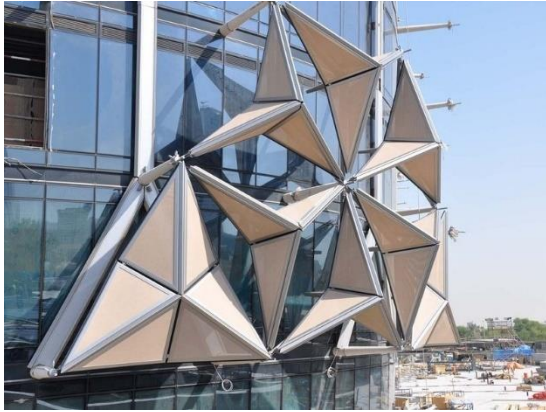
شكل (١٣) وحدات الواجهة تتفاعل ديناميكياً مع أشعة الشمس، من خلال الفتح والغلق لتوفير الطاقة الكهربائية.
