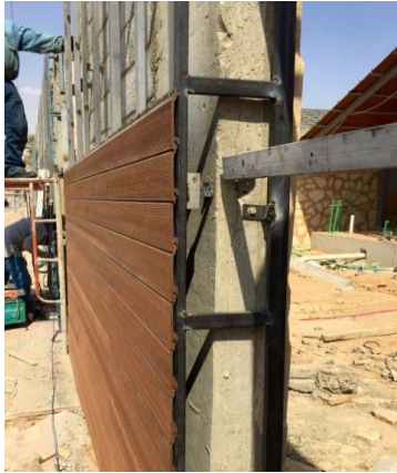
شكل (٤٠) يتم تثبيت الخشب البلاستيكي (الذكي) فوق الاسطح بواسطة هيكل وحدات التثبيت المعدنية.
