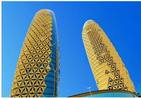
شكل (١٢) واجهة "أبراج البحر" الواجهة مزودة هيكل معدني مزود بوحدات ديناميكية قابلة للفتح والغلق أوتوماتيكياً.
