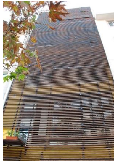
شكل (١٩ & ٢٠) واجهة ديناميكية شرائط خشبية مثبتة بمفصلات التحريك تشكل نوافذ وجلسات لأوعية الزهور، تتناغم مع المحيط البيئي.
