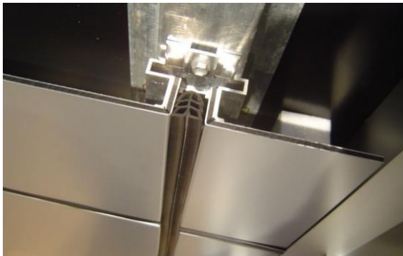
شكل (٢٩) قطاع في ألواح الكوبوند يظهر طبقات اللوح وطريقة تركيبه واتصاله مع الزاوية المعدنية، والشرايط المتواجدة بين الألواح من الكاوتشوك أو من السيليكون.
