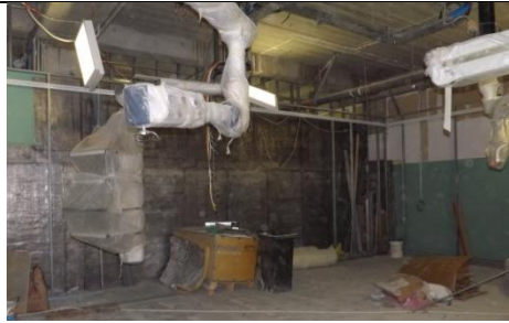
الشكل (٨-١) (٩-١) : غرفة العمليات الرئيسية لجراحات المخ أثناء عملية الإنشاء ويظهر تجهيز الغرفة بعازل الأشعاعات من الرصاص للحوائط، وتثبيت الأذرع الطبية بالسقف، بالمستشفى التخصصي بمدينة الملك عبدالله الطبية بمكة المكرمة
