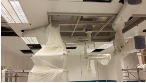
الشكل (١١-١) : وحدة الهواء أعلى سرير المريض laminar air flow، بمركز العلوم العصبية بمدينة الملك عبدالله الطبية بمكة المكرمة
