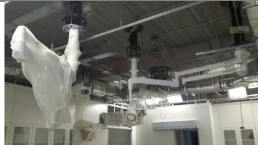
الشكل (٨-١) (٩-١) : غرفة العمليات الرئيسية لجراحات المخ أثناء عملية الإنشاء ويظهر تجهيز الغرفة بعازل الأشعاعات من الرصاص للحوائط، وتثبيت الأذرع الطبية بالسقف، بالمستشفى التخصصي بمدينة الملك عبدالله الطبية بمكة المكرمة
