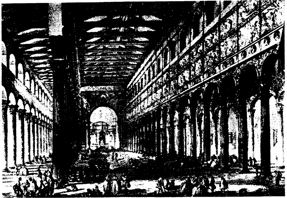
(شكل ٥٩) كنيسة القديس بولس القديمة بروما . « نقلاً عن رسم ج . ب . بيراني ، ١٧٤٩ »
