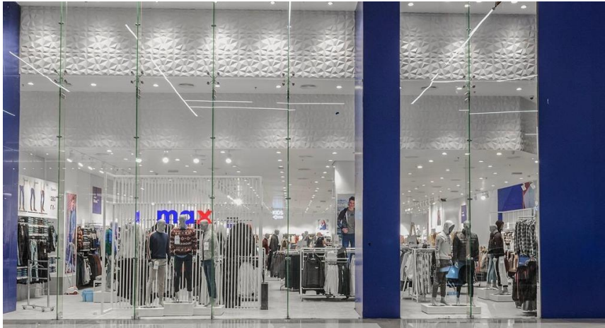
شكل (9) يوضح صورة واجهة زجاجية تم تركيبها بنظام spider system لعلامة تجارية
