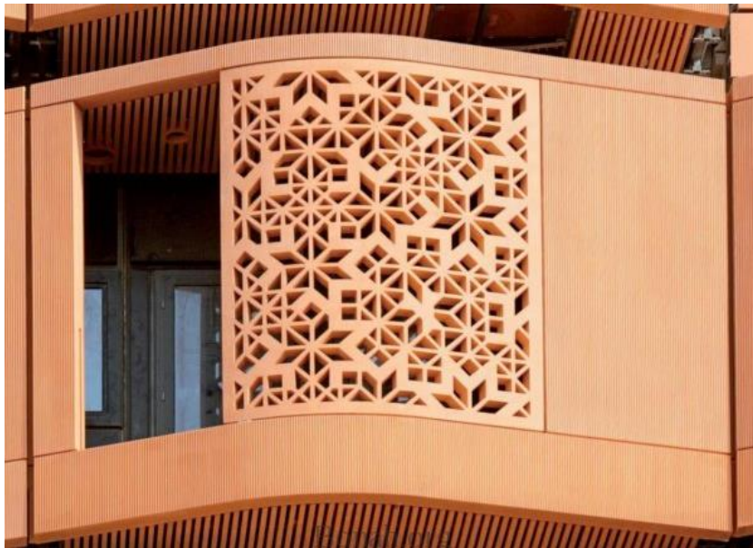
شكل ( ١٤ ) تفصيلا من الواجهة توضح جمال التشكيل في المشرييات بأستخدام خامة ال GRC في مدينة مصدر
