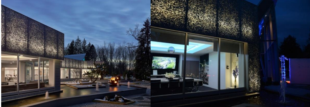
شكل (١٣) استخدام ألواح Foam Aluminum فى التكسيات الداخلية و الخارجية.
