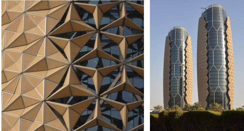
شكل (٢٣) واجهة أبراج البحر بأبوظبي المرنة المضادة للوهج الشمسي .
