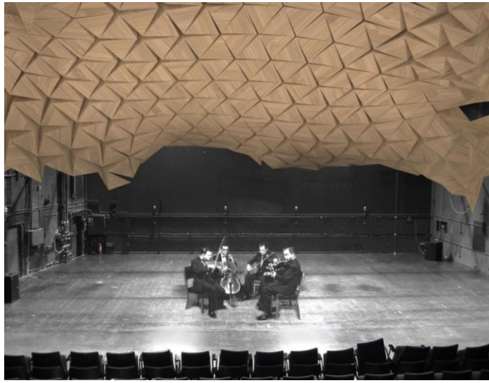
شكل (٢٠) استخدام غرف الرنين للتحكم فى ارتفاع أو اتجاه عاكس السقف و انحناء الموجة، و وقت الانعكاسات.
