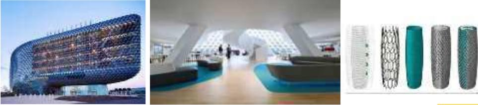
شكل ( 9 ) the South Australian Health and Medical Research Institute , تصميم " Woods Bagot" حيث الخلايا الكهروضوئية بأشكال و ألوان و مواصفات مختلفة دون التأثير على طابعها المعماري و تستخدم الخلايا الكهروضوئية الضوء المباشر لتوليد الكهرباء أما خلال فترة الليل فإن الخلايا الكهروضوئية تتوقف عن العمل لذلك يمكن تخزين الكهرباء المولدة خلال النهار في بطاريات ليتم استخدامها في ساعات الظلام .
