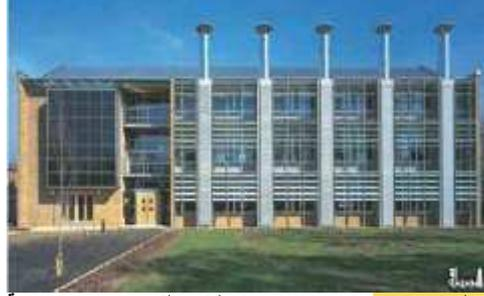
**شكل ( 12 )** مبنى مركز بحوث البناء بلندن باستخدام خمسة أبراج للتهوية على الواجهة الجنوبية حيث توفر الأبراج التهوية الطبيعية ونظام التبريد بالمبنى ففي فصل الصيف تسقط أشعة الشمس على الزجاج الموضوع أمام فراغ الأبراج فيسخن الهواء بداخلها ويرتفع الهواء الساخن إلى أعلى داخل المداخن الشمسية المصنوعة من الصلب ليحل محله الهواء البارد في الفراغات بالمبنى 17
