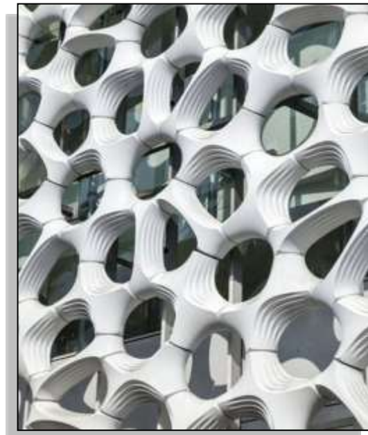
صور توضح شكل الوحدة التكراريه (الخلية) المصمم منها الشبكة المنقية للهواء على واجهة المستشفى ، وطرق تكرارها وتراصها
