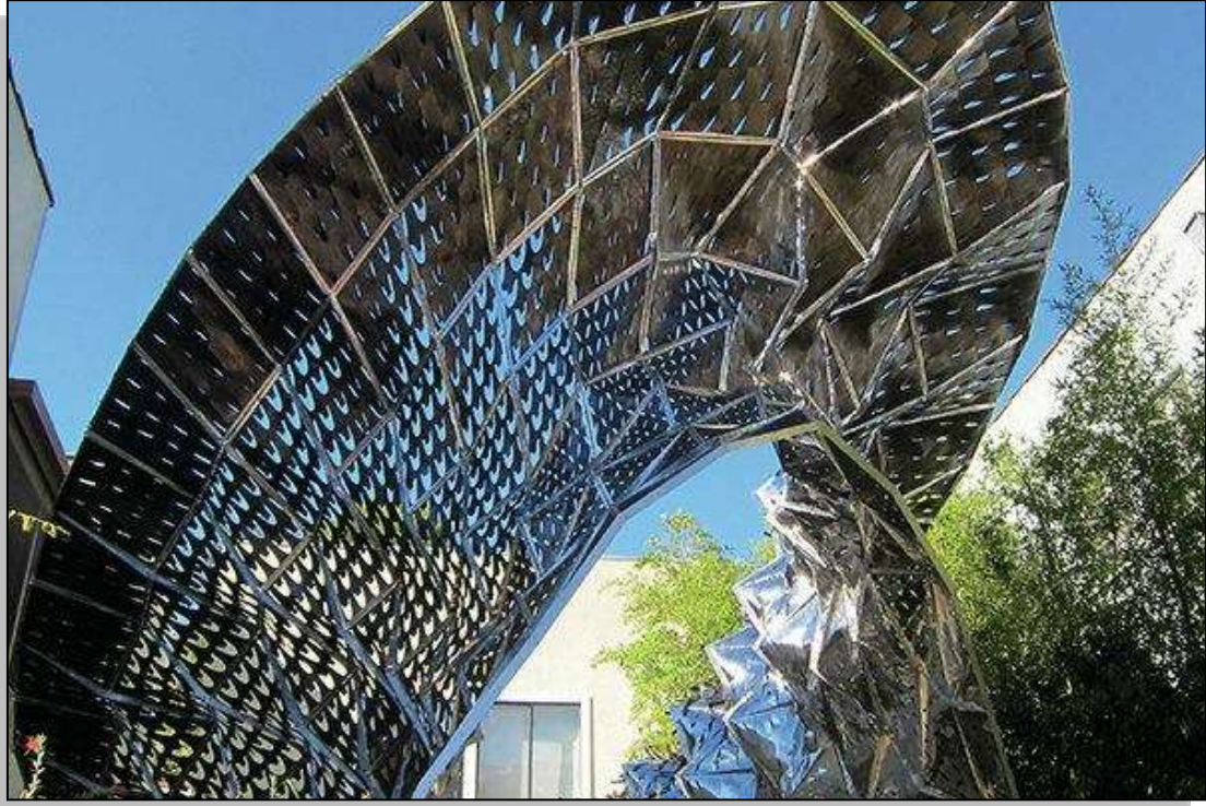
صور توضح زوايا مختلفه للهيكل المعدني اثناء فتحه وغلقه للالواح المعدنية الرقيقه
