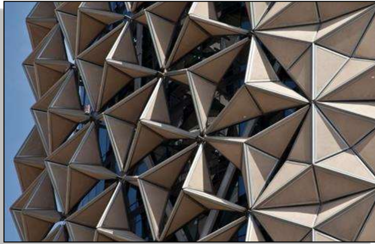
صور توضح شكل واجهة المبنى المصممه على شكل خلية مكون من وحدات تفتح وتغلق تبعا لكمية الضوء المعرضة لها
