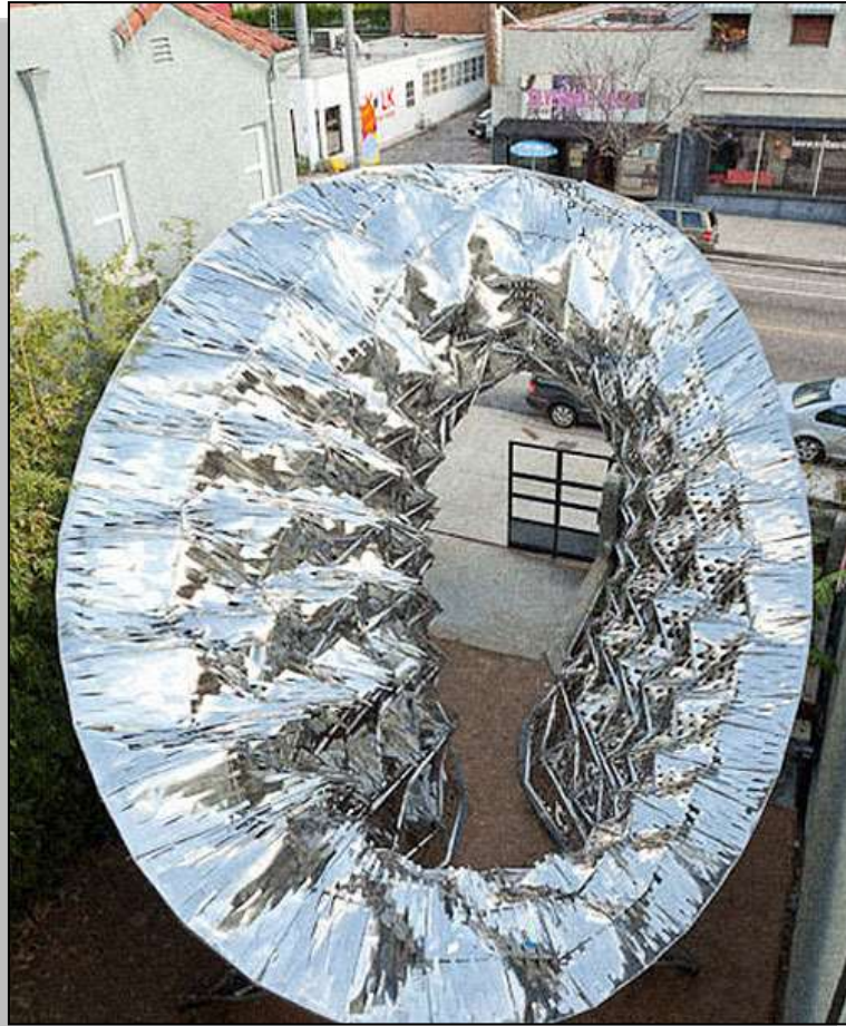
صورة توضح شكل عام للهيكل المعدني وهو مغلق اثناء النهار وارتفاع درجة الحرارة
