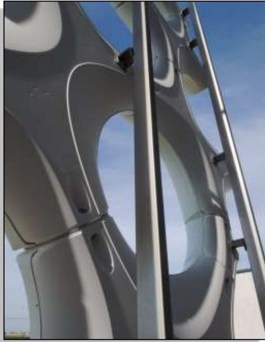
صور توضح التفاصيل المعمارية لطرق تركيب وتثبيت الواجهة المنقوية للهواء على واجهة المستشفى
