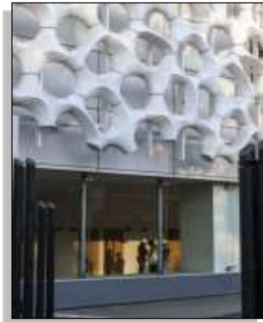
صور توضح شكل الوحدة التكراريه (الخلية) المصمم منها الشبكة المنقية للهواء على واجهة المستشفى ، وطرق تكرارها وتراصها
