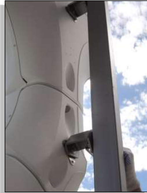
صور توضح التفاصيل المعمارية لطرق تركيب وتثبيت الواجهة المنقوية للهواء على واجهة المستشفى
