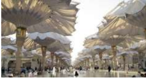
الشكل رقم (03) مجموعة من المظلات آلية الفتح والإغلاق، أثناء عملها. المصدر: تصوير الباحثة 2018م
