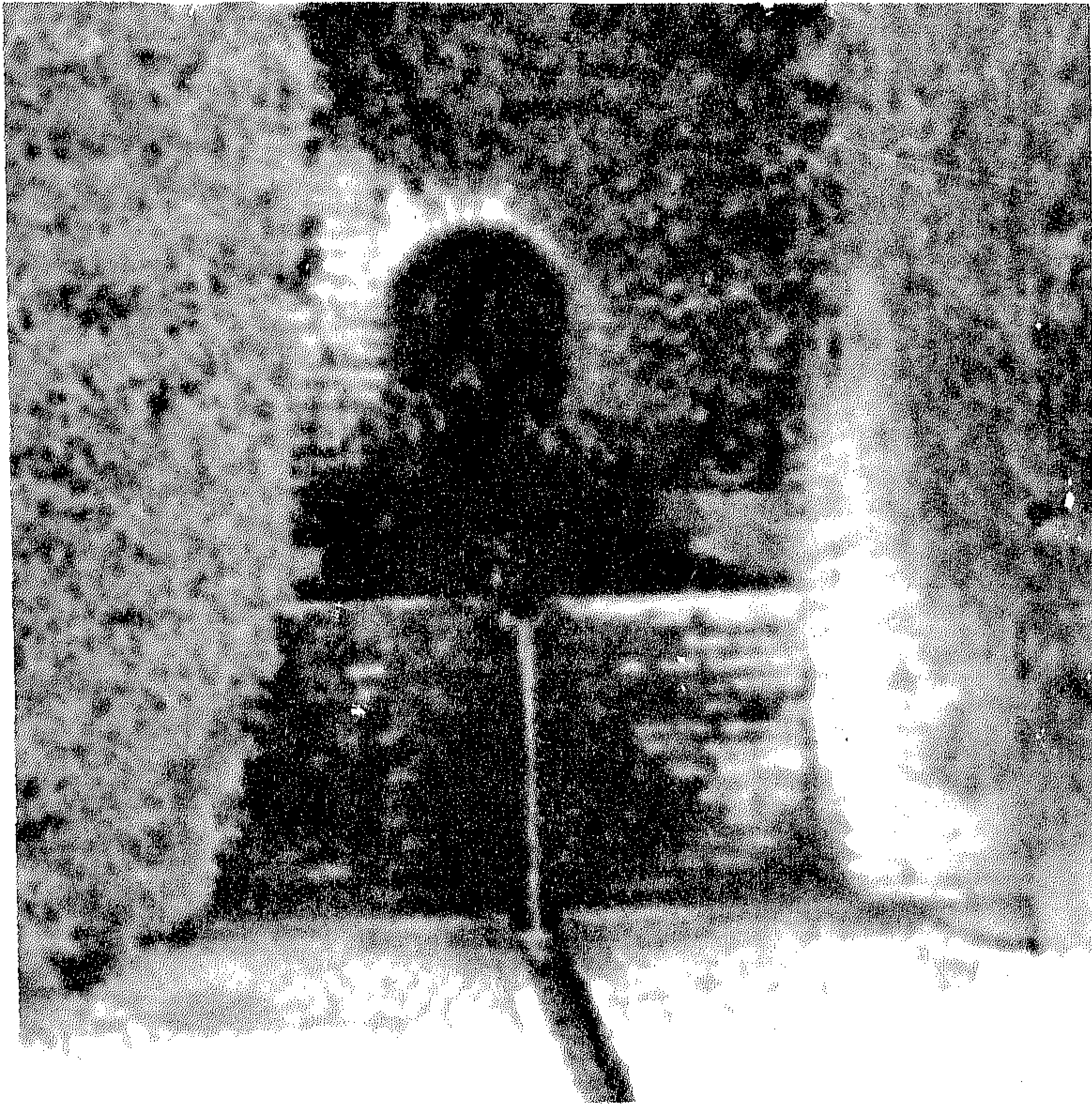
(شكل ٧) بئر تجميع يتصل بمجرى مائى مكشوف بحدائق الحمراء
