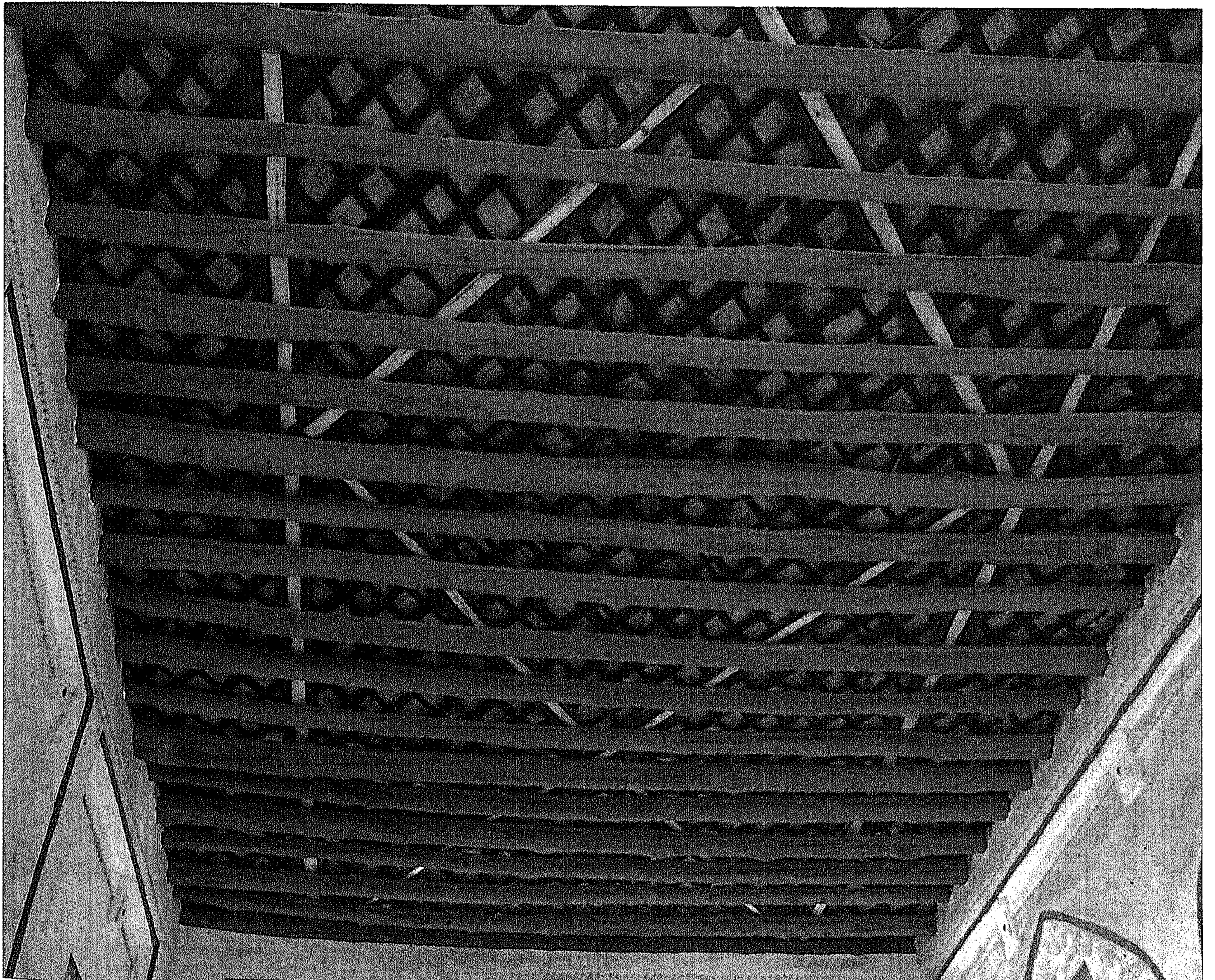
شكل رقم (193) صورة للسقف التقليدي في مساكن المحرق
