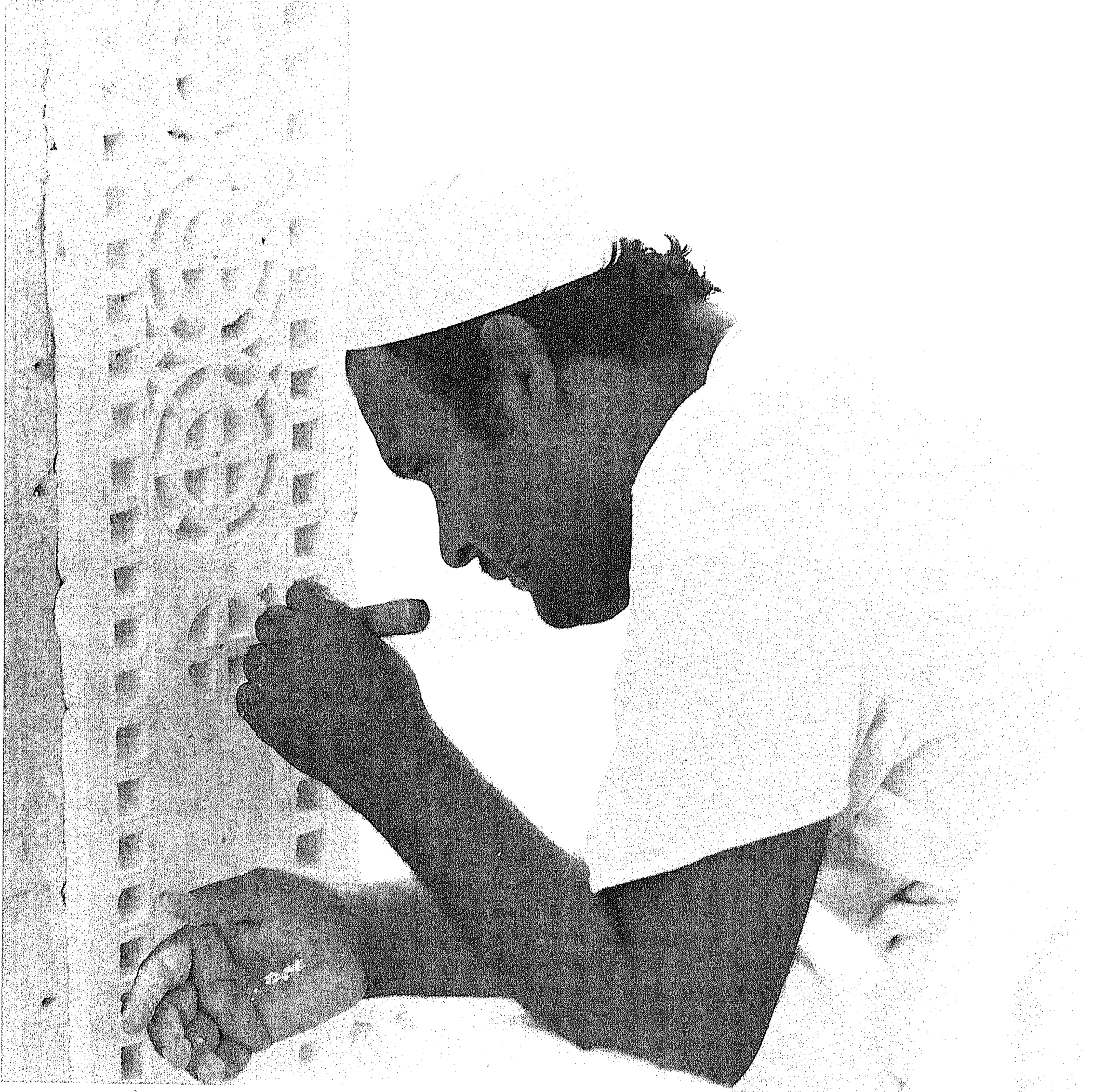
شكل رقم (266) صورة الحرفي ومراحل تنفيذ الزخارف الجصية
