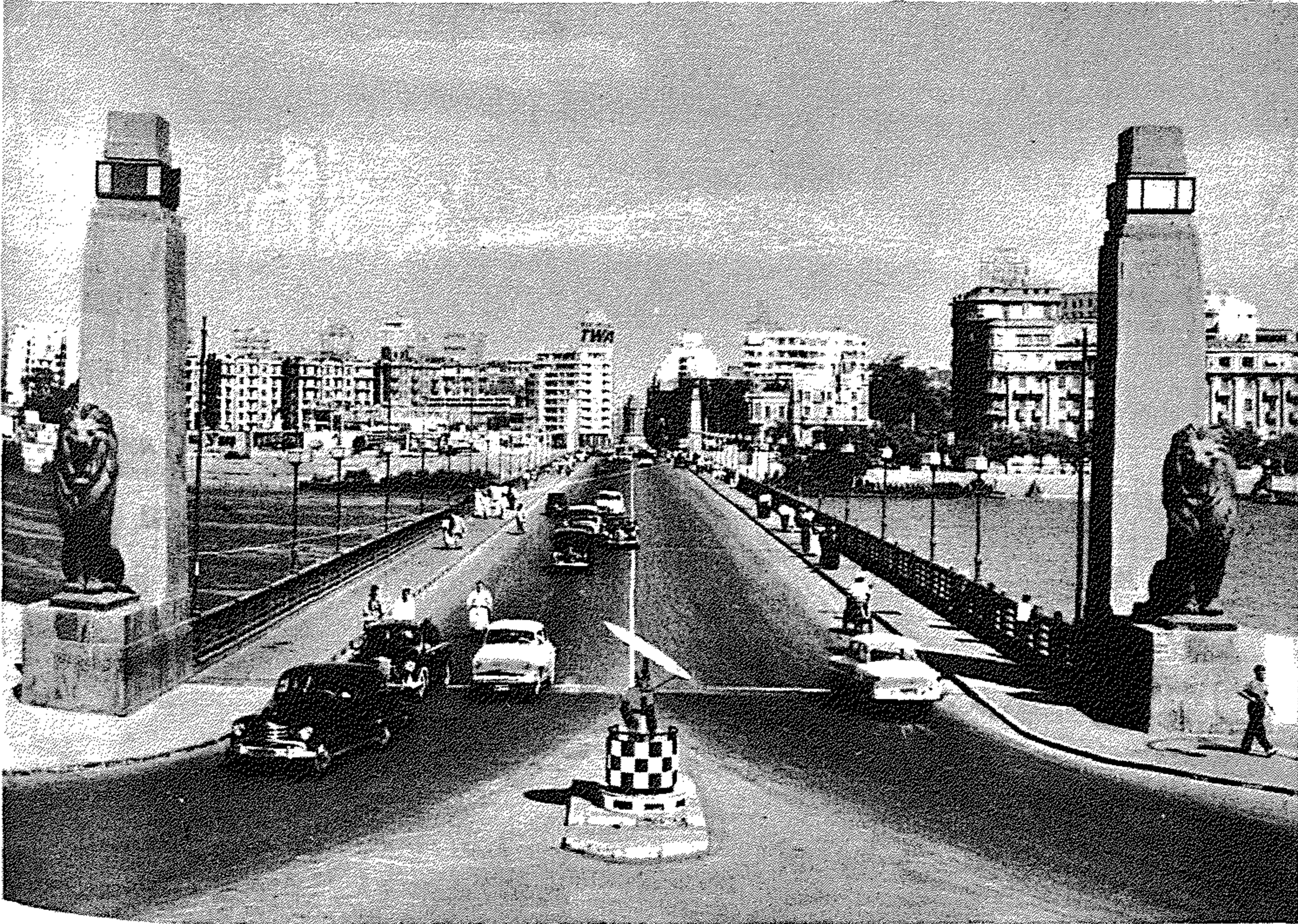
كوبرى التحرير ( قصر النيل سابقا ) ويرى في نهايته الشرقية ميدان التحرير وفندق سميراميس
