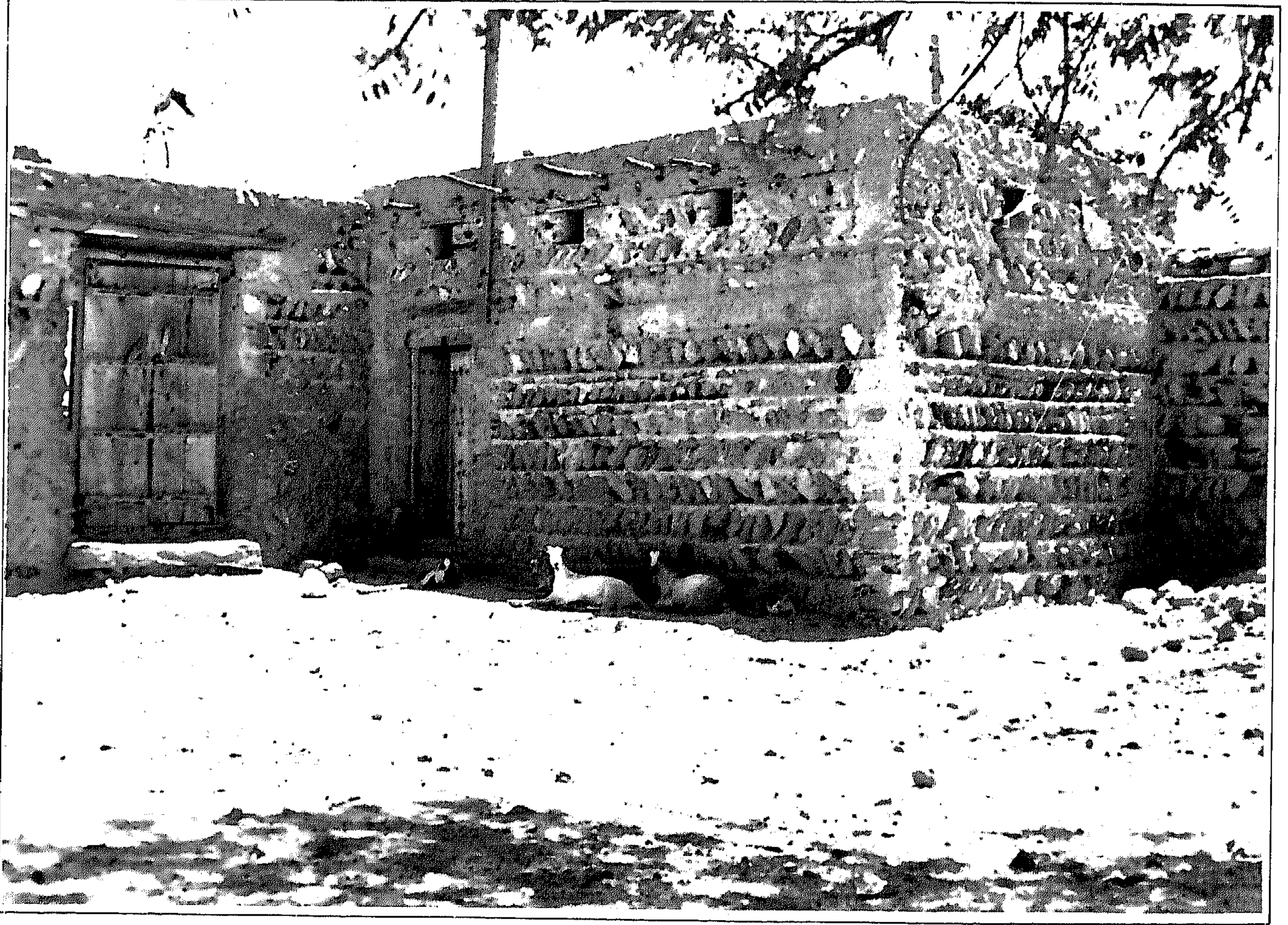
شكل رقم (٢٧) صورة المخزن (المبنى الشتوي) ويظهر فيه الفتحات والصور العالي أيضا لاحظ تقنية بناء الجدران ومواد الأسقف
