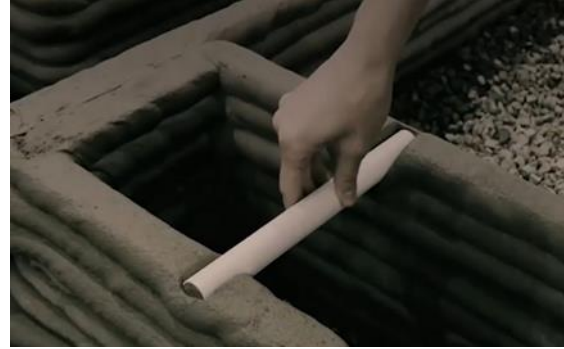
شكل (8) عمل sleeve داخل الحائط المطبوع
