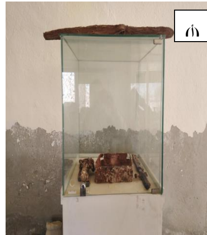
صورة (أ) توضح آثار الرطوبة على الجدران الخاصة بالمتحف مع تآكل المعادن داخل خزانه العرض
