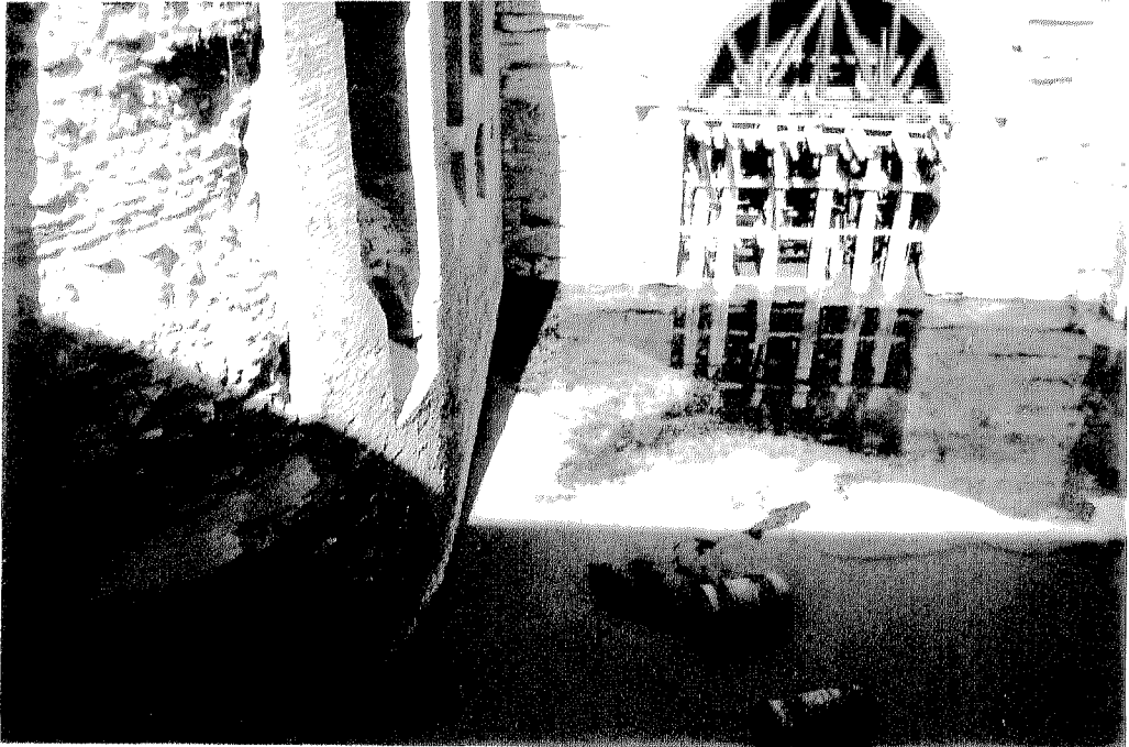
صورة رقم (١٦) توضح مدى تسرب المياه الأرضية في جدران معبد حورس بادفو
