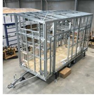
صورة ١٨: توضح جسم الشاسيه لكبينة المعيشة من الصلب المجلفن والقطاع المستخدم في الإنشاء.
