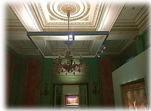
( صورة رقم ٤ ) إضاءة السقف بإضاءة إضافية بطريقة غير مباشرة - قصر عائشة فهمى - الزمالك - المصدر : الباحث .
