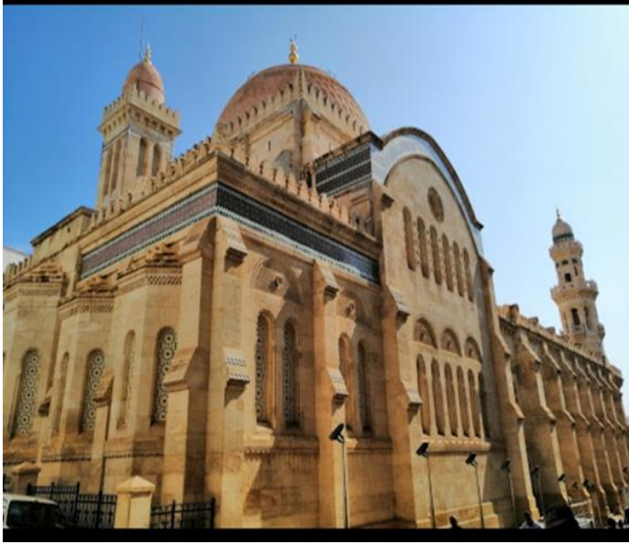
الصورة ٧: الزاوية الجنوبية لجامع كتشاوة .
