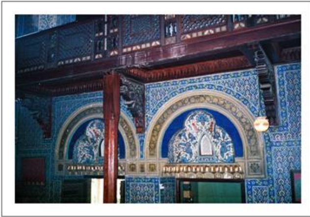
شكل (٩) يوضح تكرار العقد الدائري أعلى الأبواب، وبنفس العناصر والوحدات الزخرفية المكونة له، كما يوضح أيضا السور الخشبي المحمول على أعمدة وكوابيل خشبية متكررة على كامل محيط السور.
