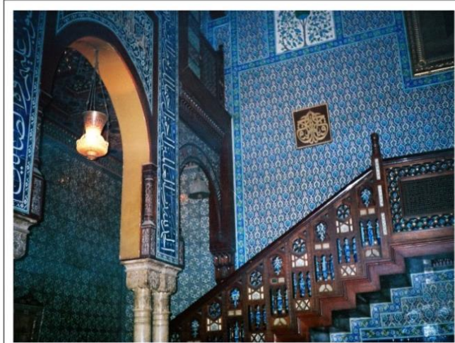
شكل (١٦) يوضح السلم الخشبي وخلفه الحائط الذي تم تكسيته بالفيشاني، كما توضح الصورة العقود التي تنوعت في أشكالها وتكسيته.
