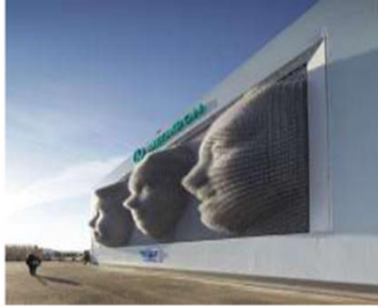
شكل (٢٠) مبنى شركة الاتصالات Msh - egafon روسيا - ٢٠١٤
