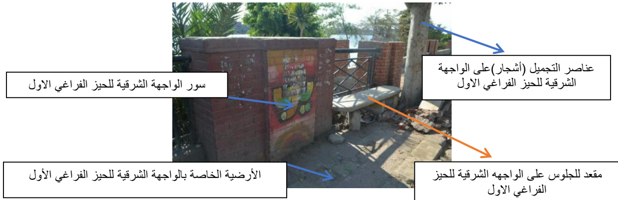
شكل (٢٦) يوضح افتقار الواجهه النيلية لعناصر التصميم الداخلي والاثاث
