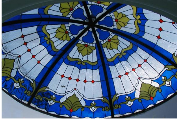
شكل ( 9 ) قبه من الزجاج المؤلف بالرصاص لاحد المساجد المعاصرة .
