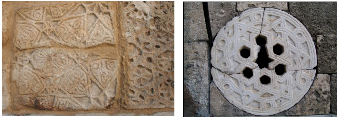
شكل(27): نماذج للتشققات والكسور التي تتعرض لها الزخارف
