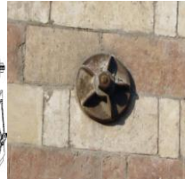
البالطة أحد أدوات التحكم في الربط. أدوات الربط بلجنة حفظ الآثار العربية. حرف ال T أحد أدوات التحكم في الربط
