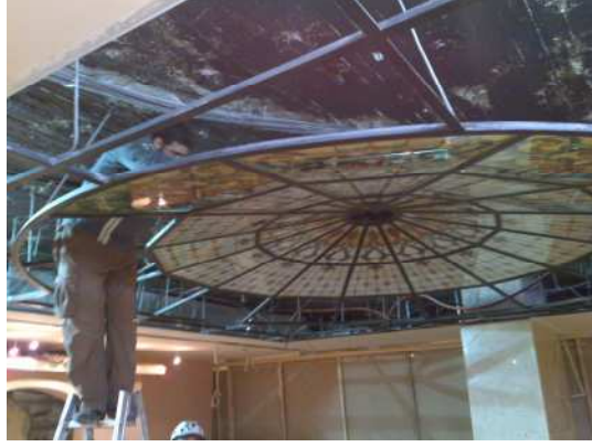
الشكل أعلاه يبين عملية تثبيت الحشوات في أماكنها
