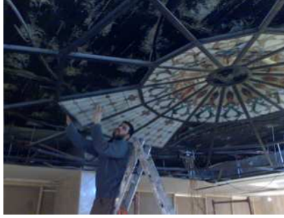
الشكل أعلاه يبين عملية تثبيت الحشوات في أماكنها
