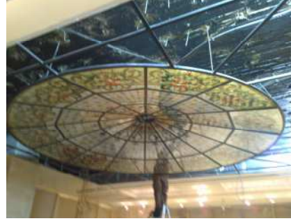
الشكل أعلاه يبين عملية تثبيت الحشوات في أماكنها
