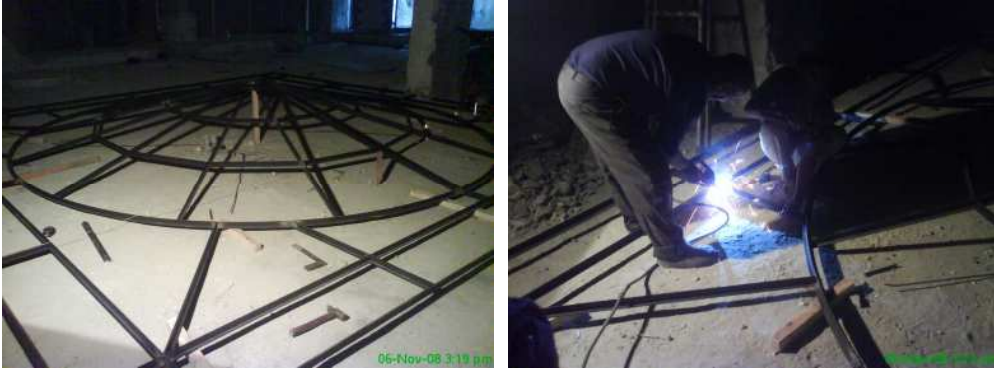
الشكلان أعلاه يبينان تجهيز الشاسيه الحديدي و لاهامه بعد عملية تجزئته الى اربعة اجزاء لسهولة تداوله
