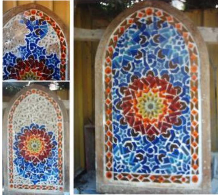
الفتحات أثناء الترميم
