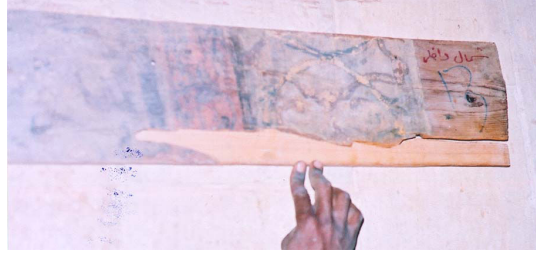
صورة رقم (17) توضح تشكيل الجزء المفقود في السقف الخشبي الملون من نفس نوع الخشب المستخدم في السقف
