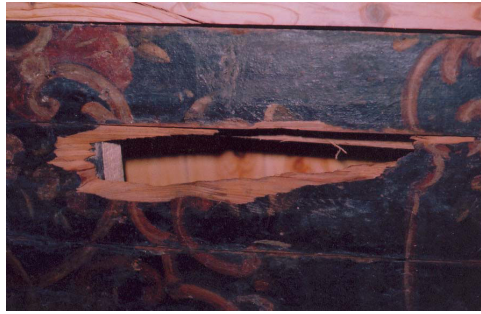
صورة رقم (13) توضح تلف الطبقات الملونة وفقدان بعض الأجزاء الخشبية في سقف سبيل حسن باشا ظاهر
