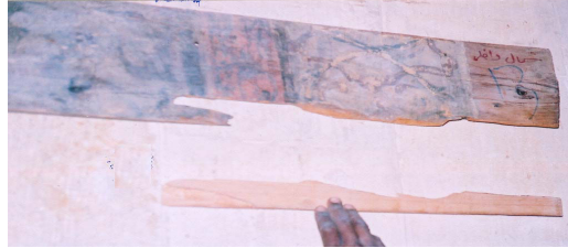
صورة رقم (18) توضح استكمال الجزء المفقود بلوح خشبي من نفس النوع المستخدم في هذا السقف
