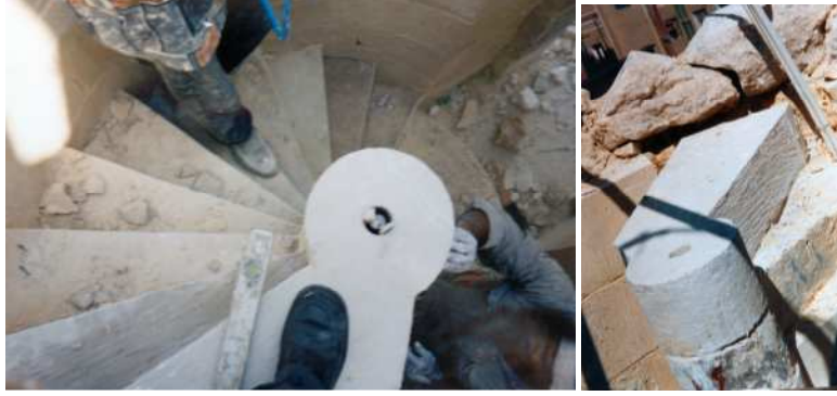
ربط عمود الدرج الداخلي بالحديد والرصاص.
