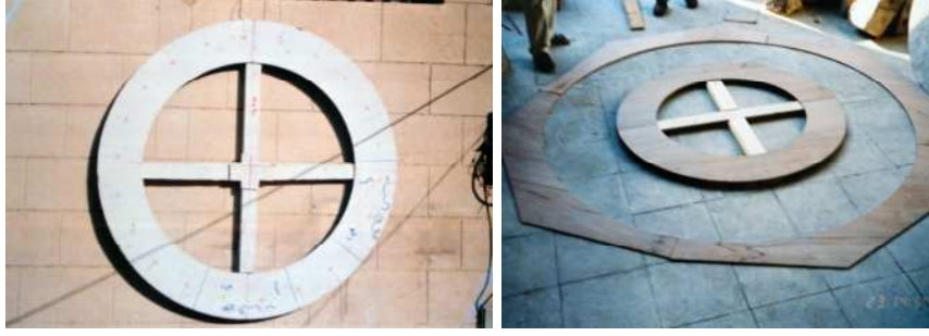
إعداد الدوائر الأفقية وتوقيع فتحات الأبواب وقوائم الدرج لضبط أفقية عملية التركيب.
