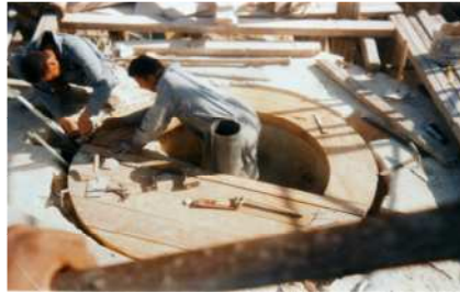
بلطة قاعدة الساري الخشبي وتسقيف مسطح الدائرة وعمل منطقة الإنتقال الداخلي.
