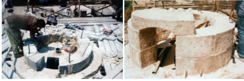
جانب من أعمال إعادة تركيب الدورة الرابعة.
