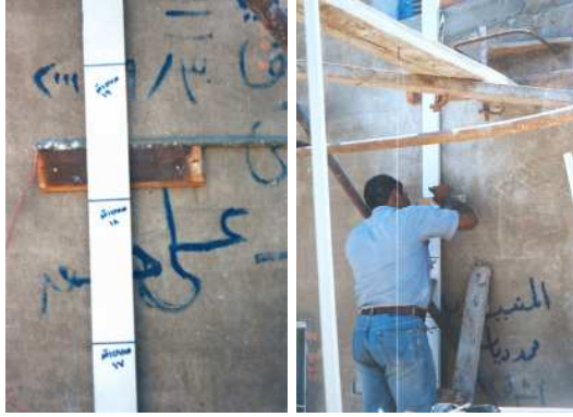
إعداد المساطر الرأسية وتوقيع قوائم الدرج لضبط رأسية عملية التركيب.
