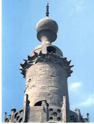
الدورة الثالثة ومداميك المقرنصات المسننة التي ترتكز عليها الدورة الرابعة الحاملة لقمة المذئنة.
