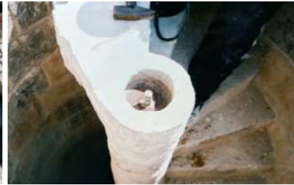
بلطة قاعدة الساري الخشبي وتسقيف مسطح الدائرة وعمل منطقة الإنتقال الداخلي.
