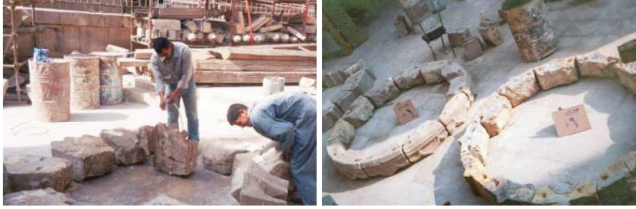
فرز القطع البنائية المكونة لدواميك المئذنة ورضها على نفس مساطب تركيبها في الطبيعة.
