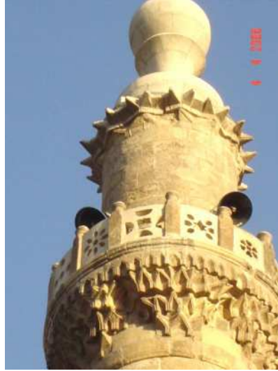
تفاصيل تكوين التحول الراسي للمئذنة بعد الترميم.
