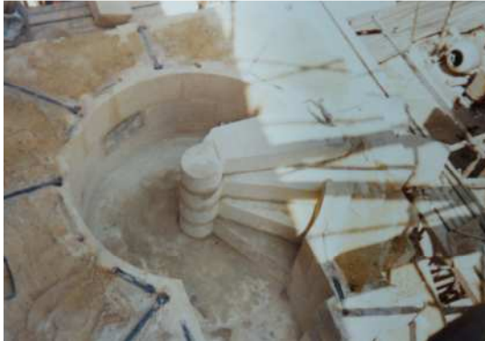
نهاية مباني القاعدة المربعة تمهيداً لبدء الإنتقال.
