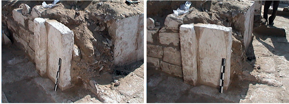
أ ب صورة رقم (18 أ، ب) القطعة الحجرية بعد عملية إعادة التثبيت
