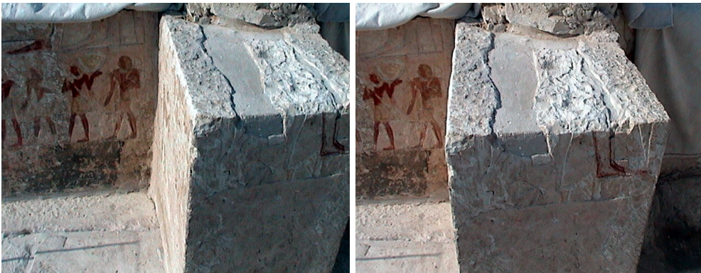
صورة رقم (30) أ، ب) توضح طريقة استكمال الأجزاء المفقودة بين الكتل الحجرية باستخدام مونة الجير وكسر الحجر الجيري
