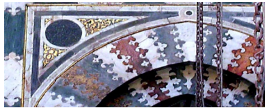
شكل رقم 2: تعاشيق الوحدات الرخامية المزرة بعقد المحراب
