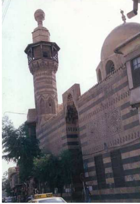
(لوحة 45) دار القرآن الصابونية: الواجهة الشرقية الرئيسية وتظهر بها القبة والمنذنة
