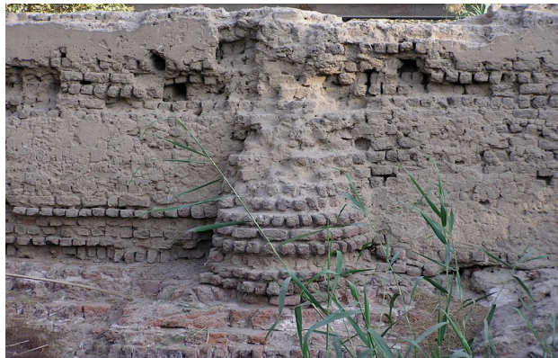
لوحة 4: تفاصيل طريقة البناء والدعامة السائدة للسور
