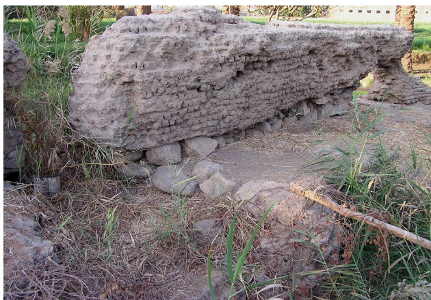
لوحة 5: التدعيم بالحجر أسفل مداميك سور القناة
