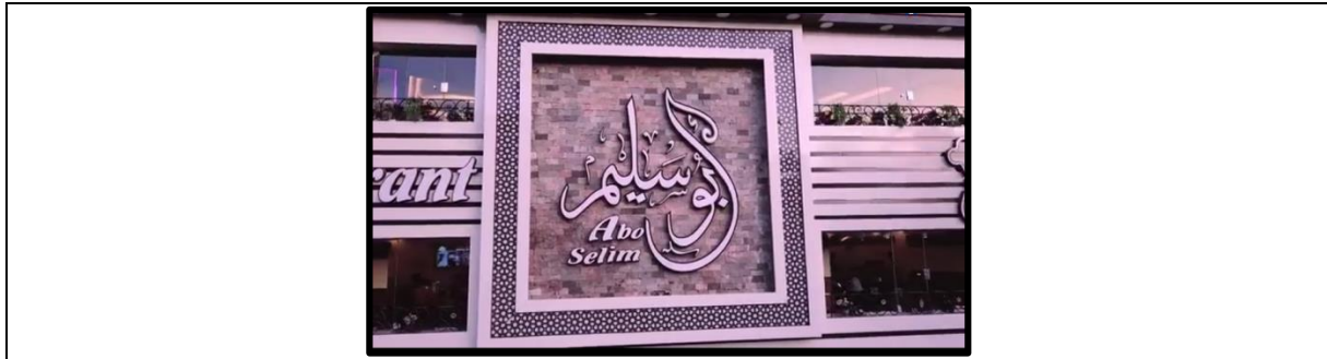
صورة (7) توضح شكل الواجهة بعد تنفيذها على ارض الواقع صورة نهائية
