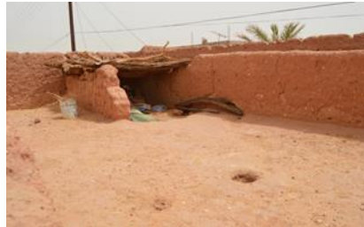
اللوحة (50) عين الدار، الهردة لتهوية المنزل موجودة في السطح التقليدي-من تصوير حرمة محمد-مأخوذة من قصر تازولت-أدرار-
