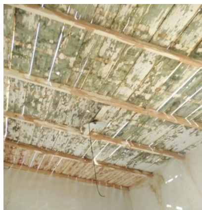
(لوحة ٥٩) سقف الصالة الكبرى بالإستراحة الصيفية بطريق قفط القصير (تصوير الباحث)
