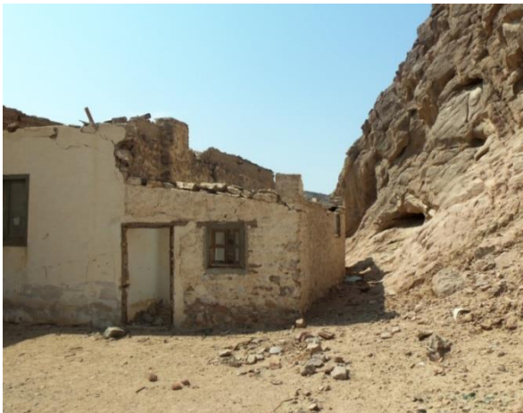
(لوحة ٤٦) الواجهة الشمالية بالإستراحة الكبرى الشتوية بطريق قفط القصير (تصوير الباحث)
