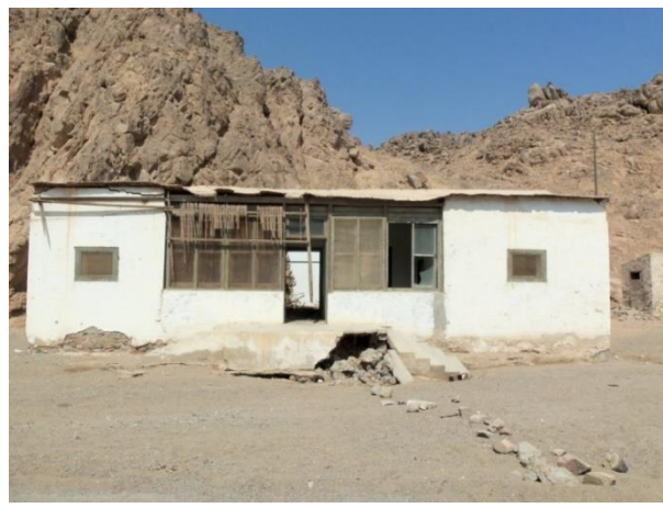
(لوحة ٤٣) الواجهة الجنوبية بالإستراحة الكبرى الشتوية بطريق قفط القصير (تصوير الباحث)
