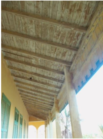
(لوحة ٣٨) سقف الشرفة الجنوبية الشرقية بالطابق الثاني باستراحة شركة الفوسفات بالقصير (تصوير الباحث)
