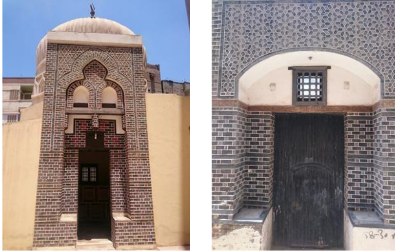
شكل ( 8 ) استخدام الطوب في واجهات المباني الاثرية في مدينة فوه ، المصدر : الباحثين
