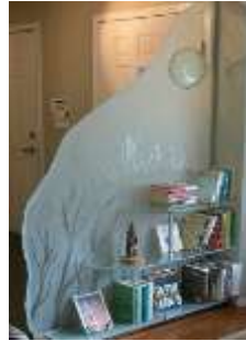
شكل ( 20 ) و يتضح الاستفاده الوظيفيه في تصميم فاصل من الزجاج السيکوريت المعالج بالحفر بالرمال مع تثبيت وحده ارفف زجاجيه و حوامل من الاستانلس ستيل.
