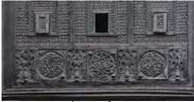
شكل (7) يوضح الزخارف النباتية المجردة في حشوات الجزء السفلي لأحد مشربيات منزل زينب خاتون (تصوير الباحثة)
