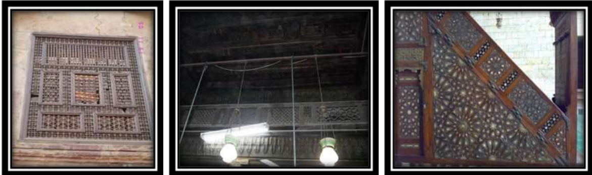
لوحة رقم (8): الخرط الدقيق من النوع المسدس بأشغال الخشب في: مدرسة برسباي وجامع البرديني وجامع الخواجا محمود محرم بمدينة القاهرة (عن: الباحث).
